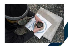
KALKISS SP® bénéficie de la technologie exclusive SmartCEM® développée par EDYCEM. Elle permet d'identifier rapidement le type de produit mis en œuvre. Grâce à l'application smartphone, les applicateurs disposent en temps réel des informations liées à la vie de la chape : nature du liant, résistance mécanique, marquage CE du procédé, référence de l'avis technique en vigueur, nom du titulaire du DTA en vigueur, site de production et date de mise en œuvre.
